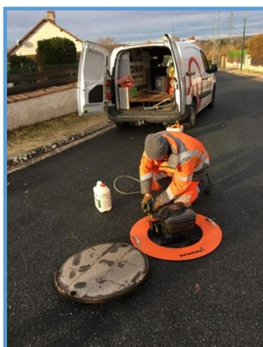
Contrôle des raccordements au test de fumée au lotissement des Maisons Rouges
